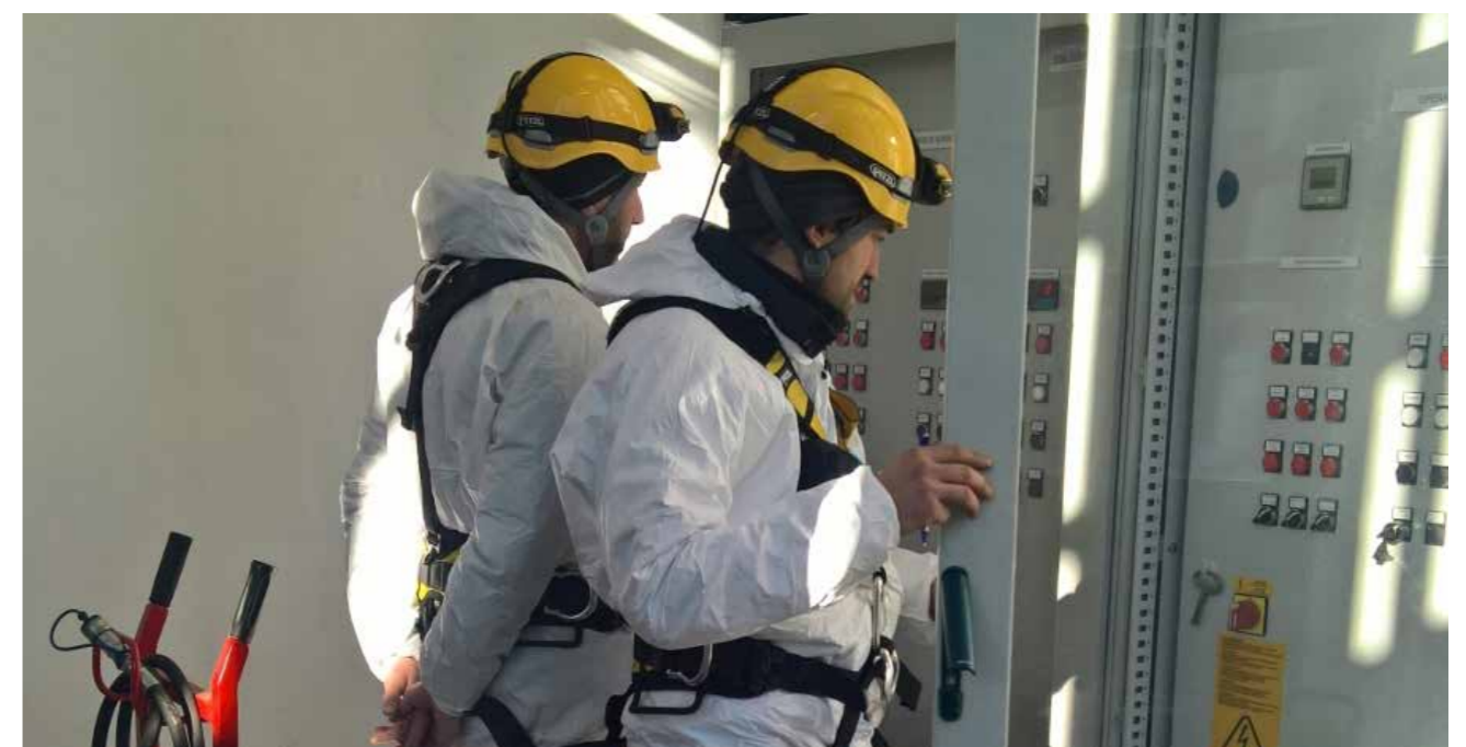
Attività manutentive su impianto idroelettrico
