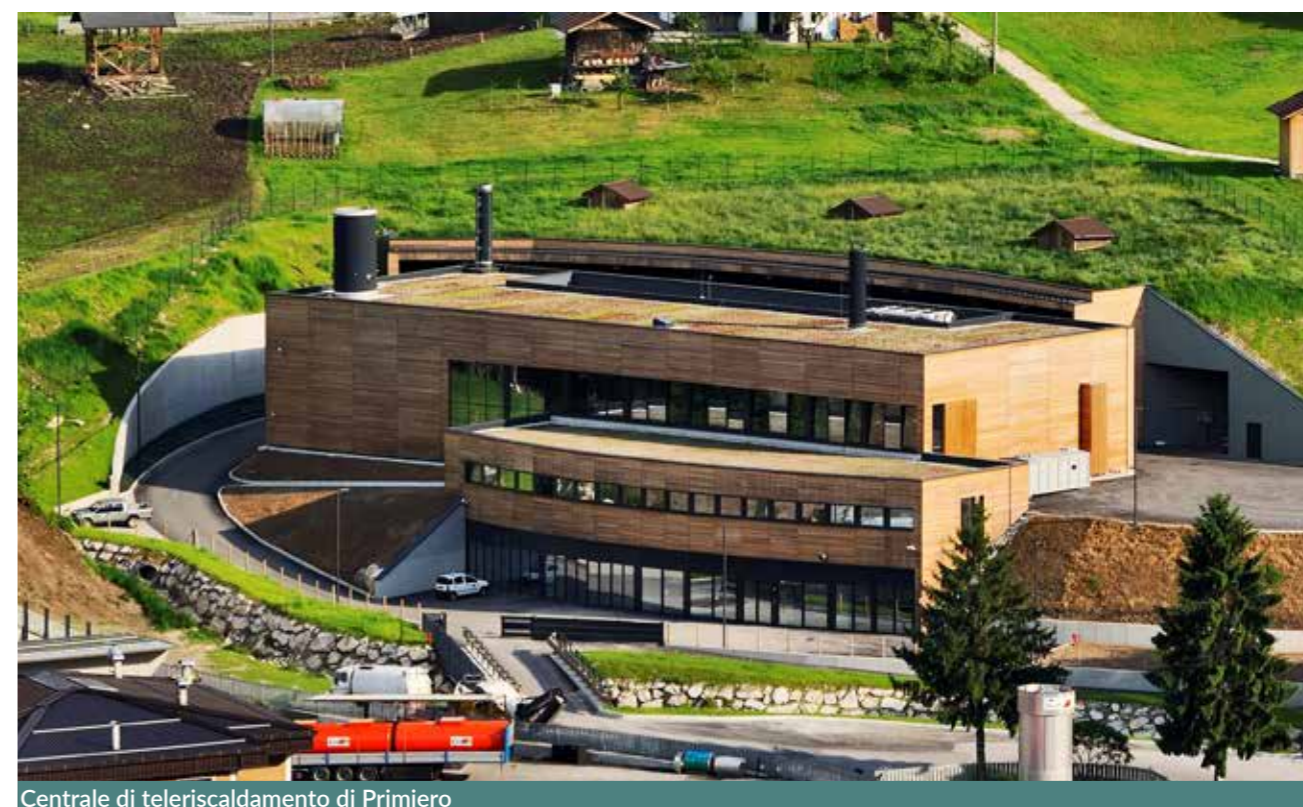
Centrale di teleriscaldamento di Primiero
