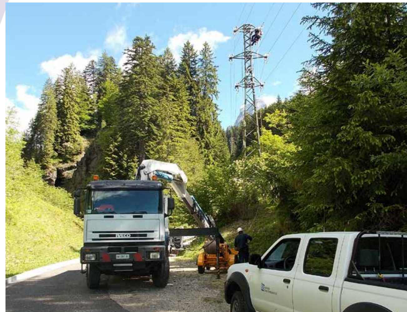
Personale al lavoro su linee elettriche
