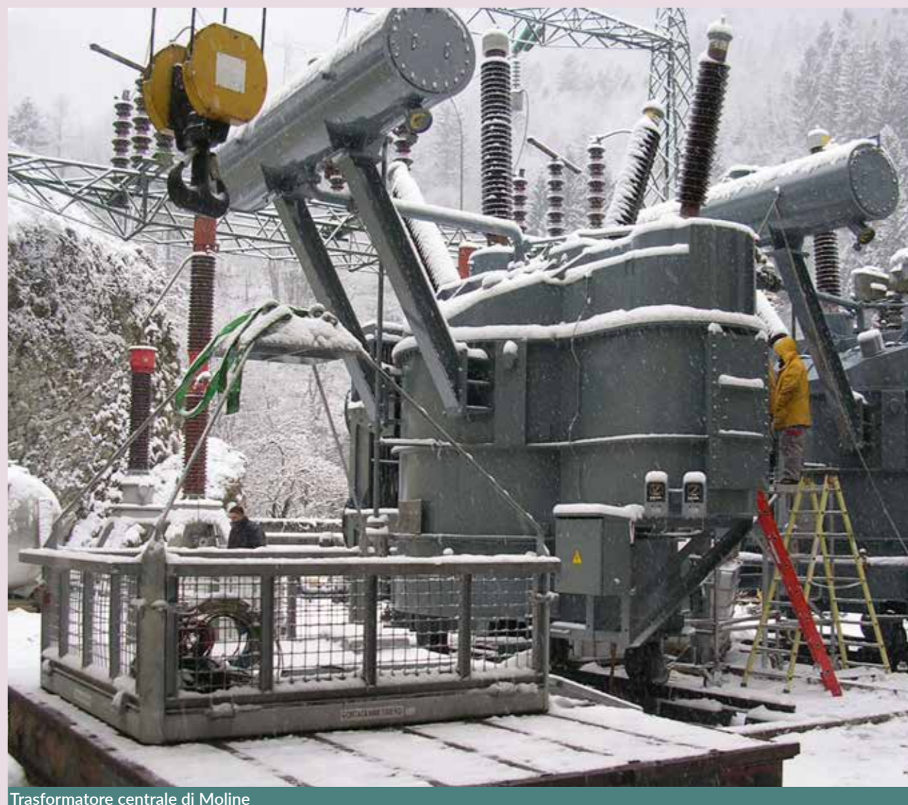
Trasformatore centrale di Moline
